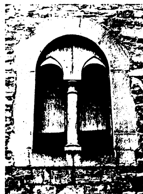
Dieses gekuppelte Zwillingsfenster im hochliegenden Erdgeschoss wurde nach Vorlage alter Pläne erneuert.
