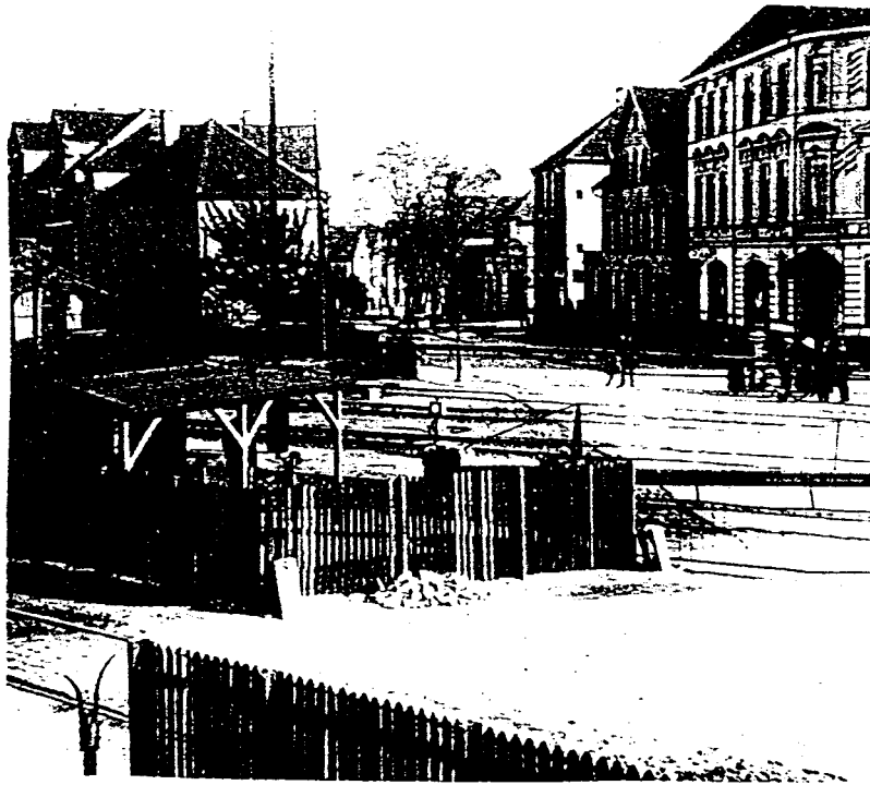
Abb. 14: Bahnübergang Buersche Straße 110
