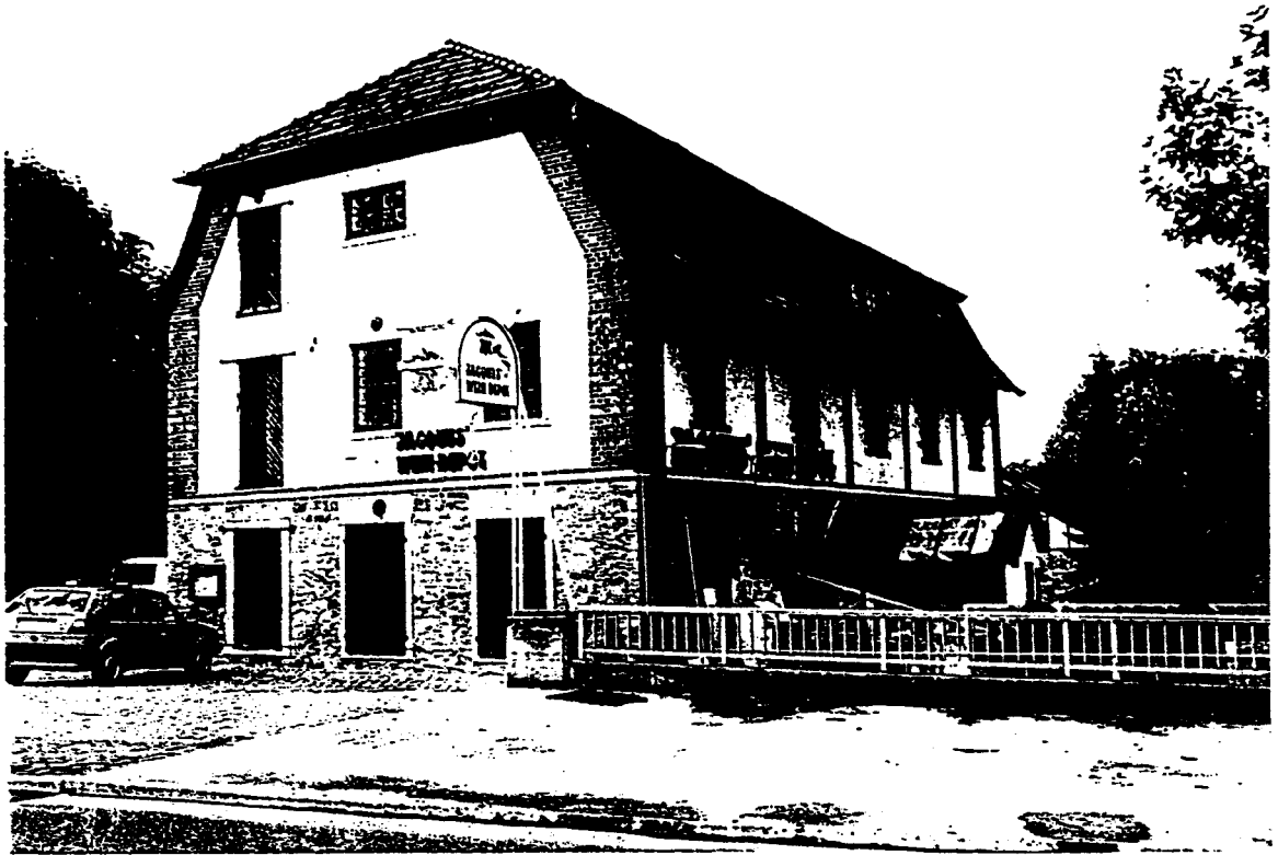
Abb. 8. Blick auf das Mühlenhauptgebäude mit dem kleinen Anbau, in dem die Kesselturbinenanlage untergebracht ist, von der Hansastrasse her.
