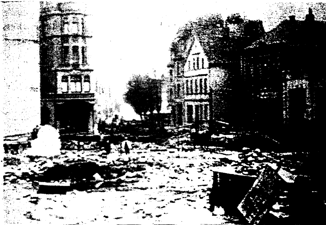
Abb. 6: Straßenarbeiten im Kreuzungsbereich Buersche-/ Schinkelstraße 20
