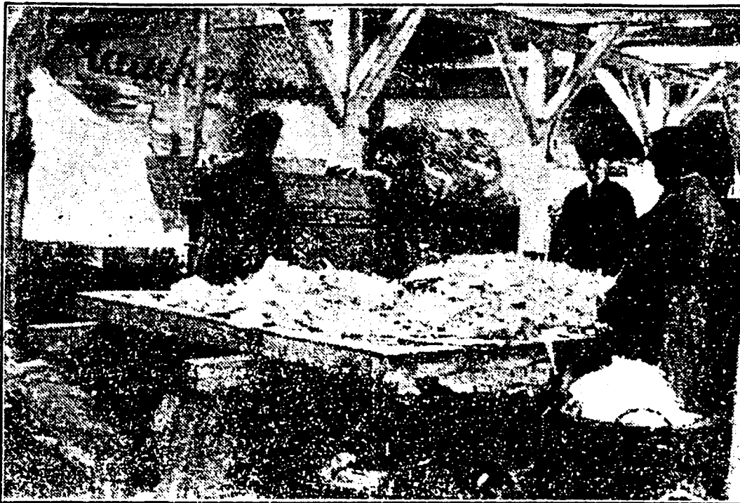
Abb. 14: Innenansicht des Werkhofes, Osnabrücker Zeitung, 31. Januar 1929
