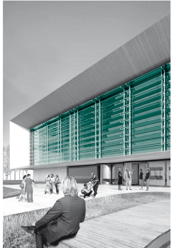
Abb. 7 3E-Gebäude der TU Wroclaw (Breslau)
