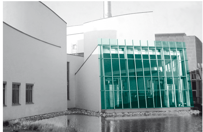
Abb. 21 Einsicht in den Heizungsraum des Energieforums in Bad Oeyenhausen Fig. 21 A look at the boiler room of the Energieforum in Bad Oeyenhausen
