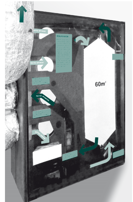
Abb. 87 Einblick in das Innenleben eines Wärmetauschers (Demonstrationszentrum Bau und Energie in Münster) Fig. 87 A view into the interior of a heat exchange device (Demonstration Center Construction and Energy in Munster)
