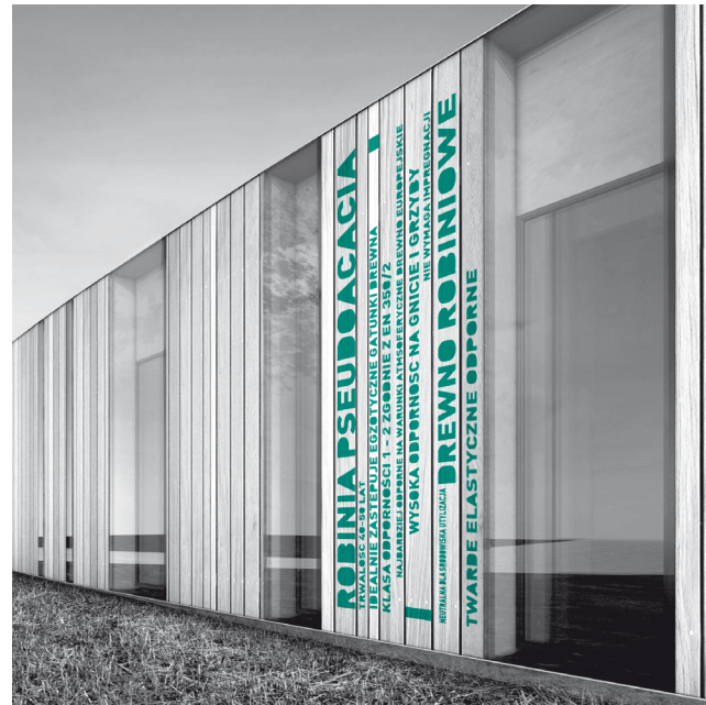
Abb. 55 Die unbehandelte Robinienholzfassade mit Informationen über die Baustoffe Fig. 55 Untreated robinia wood façade with information about building materials
