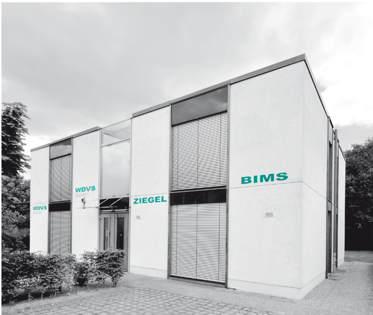
Abb. 17 Exponierter Wandaufbau, Demonstrationszentrum Bau und Energie in Münster Fig. 17 Labeled wall structures, Demonstration Center for Construction and Energy in Münster
