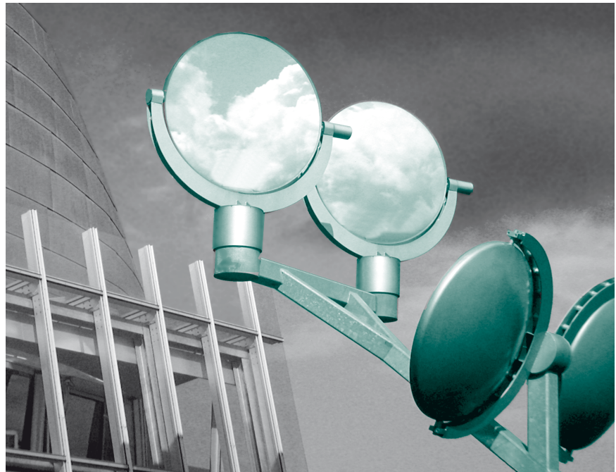
Abb. 36 Heliostaten vor dem Energieforum in Bad Oeynhausen
